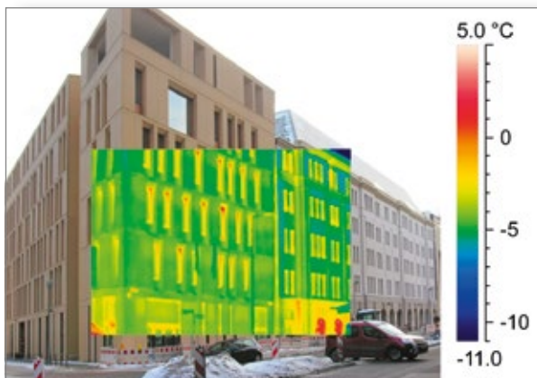
Thermografie der Straßenfassade von Alt- und Neubau des BMUB in Berlin zur Überprüfung der Ausführungsqualität
