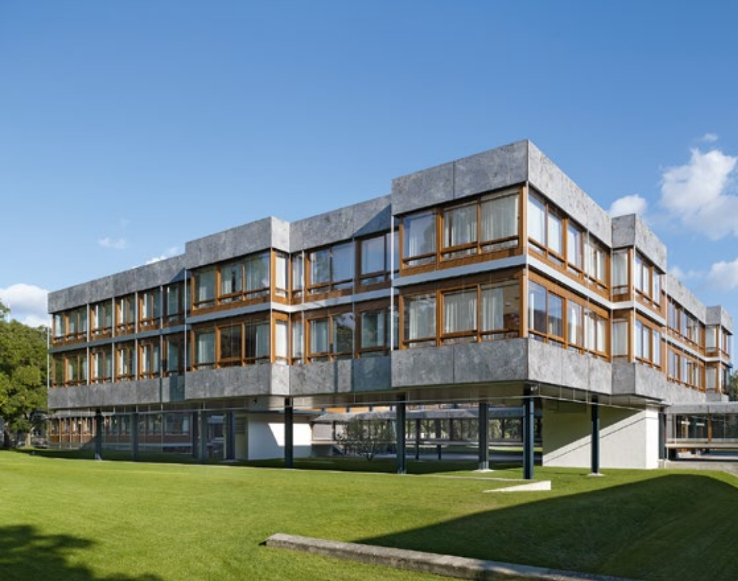
Rekonstruierte, denkmalgeschützte Fassade des Bundesverfassungsgerichts nach Schadstoffsanierung
