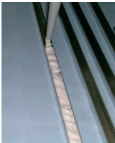
Bild 5: Einbringen einer Dichtungsmasse in eine Aluminium-U-Profilsschiene
